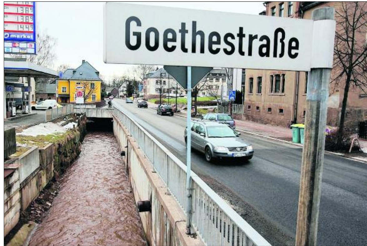
Von der Goethestraße an in Richtung Poststraße wird ab April gebaut. Die Hofer Straße, als Bundesstraße für den Verkehr zwischen Zwickau und Chemnitz wichtig, kann dann nur noch in eine Richtung genutzt werden. Autofahrer müssen sich auf Umleitungen einstellen.
